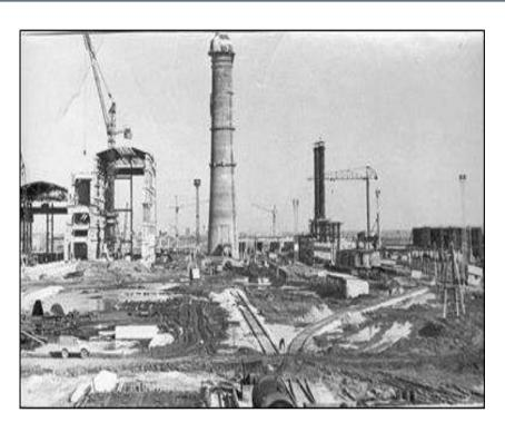
Строительство ТЭЦ ВАЗа было начато в 1966 году и осуществлялось в две очереди. В ноябре 1967 г. был начат отпуск тепла потребителям от водогрейных котлов, а в декабре 1969 г. пущено первое энергетическое оборудование. Проектная мощность ТЭЦ 1172 МВТ достигнута в 1987 году с вводом последнего одиннадцатого турбоагрегата.
