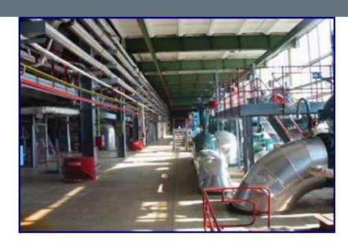
Котельный цех — **14 энергетических котлов** в главном корпусе, **9 котлов** ТГМ-84 паропроизводительностью по 420 т/ч и **5 котлов** ТГМЕ-464 паропроизводительностью по 500 т/ч производства Таганрогского завода «Красный котельщик».
